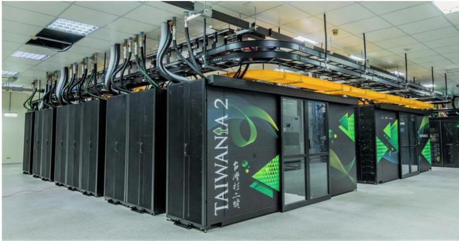
圖七：國家高速網路運算中心機房-臺灣杉 2 號(液冷)
